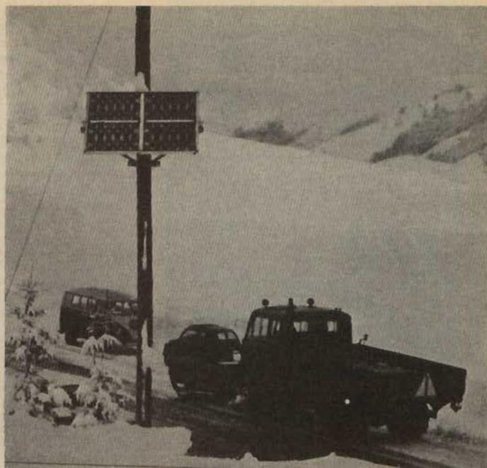
Fig. 4 - Pannelli e cellule solari utilizzati per l'alimentazione di una linea telefonica della SIP in Abruzzo (Passo Lodi).
